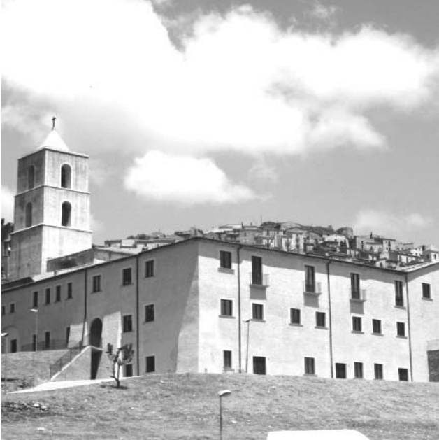
L'ex-convento cinquecentesco di Santa Maria del Gesù a Viggiano che ospiterà la Fondazione Eni «Enrico Mattei» appena saranno ultimati i lavori
